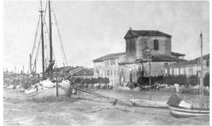
Una fiumana passata prima dell'esistenza del ponte de La Resistenza
